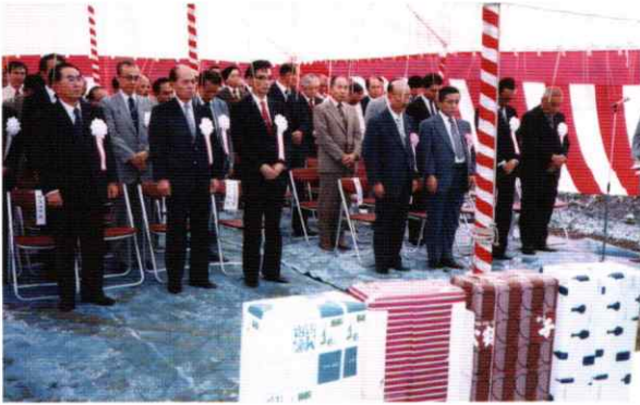
昭和58年（1983）東山区 2代目会館 地鎮祭・起工式
