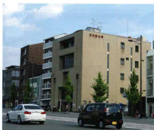
京都府柔道整復師会館外景
