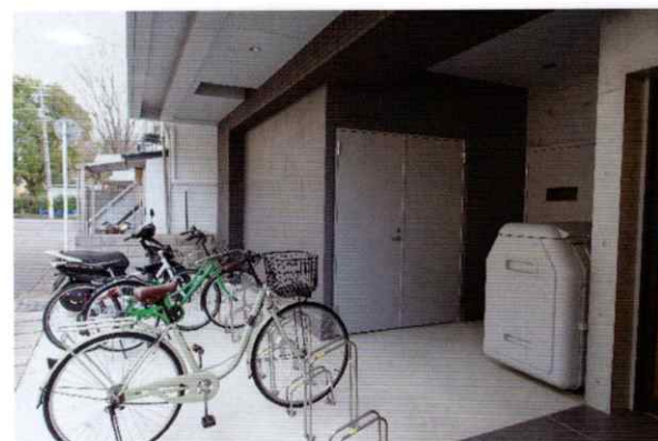
⑪ 1階屋外倉庫
